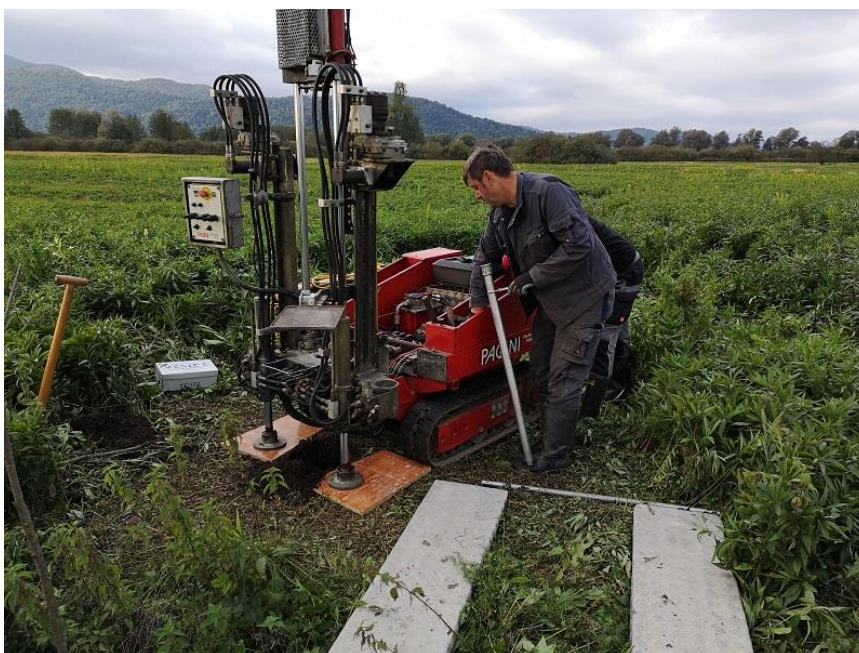
Slika 4: Nameščanje piezometrov.
